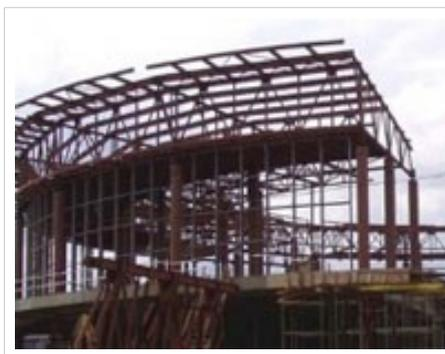
Спортивные сооружения на основе металлического каркаса представляют собой быстровозводимые легкие и надежные здания. Прежде всего, устраивается столбчатый либо сваенабивной фундамент, на котором монтируется основной каркас. Он представляет собой систему вертикальных колонн, которые связаны между собой горизонтальными фермами. В качестве обшивки обычно используются сэндвич-панели или профнастил. Эти же материалы могут быть использованы для устройства кровли.
