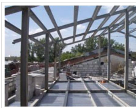
Прогоны представляют собой горизонтальные конструктивные элементы каркаса сооружения, которые служат опорой для установки настила, в том числе кровли и обшивки фасада. В свою очередь прогоны опираются на несущие конструктивные элементы – фермы или балки. Прогоны являются наиболее распространенными вспомогательными элементами несущих конструкций. В случае использования в качестве основы для кровли, прогоны передают нагрузку от кровельного материала на стропила.
