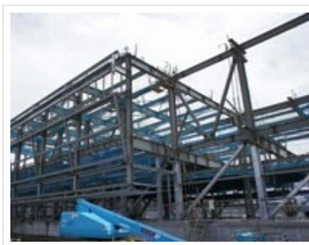
Здания каркасного типа представляют собой конструкцию из колонн, балок и прочих металлических несущих и вспомогательных конструктивных элементов, пространство между которыми заполняется высокоэффективными звуко- и теплоизоляционными материалами.
