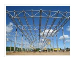
Ферма – сборная решетчатая конструкция, состоящая из определенным образом соединенных между собой стержневых элементов. Основное назначение фермы – восприятие нагрузки от перекрытий, в том числе от плит перекрытия. При этом на пролетах большой длины металлоемкость фермы значительно ниже металлоемкости сплошной металлической балки.
